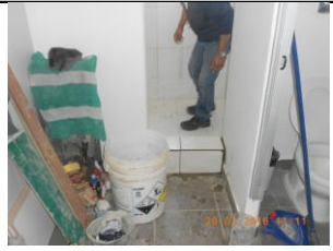
Figura 2. Reparación de duchas en cuadras de suboficiales, Edificio Administrativo B
